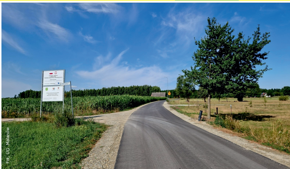
Wyremontowana droga w miejscowości Poroże
