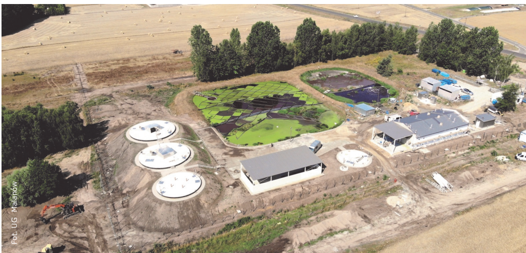
Oczyszczalnia ścieków w trakcie budowy
